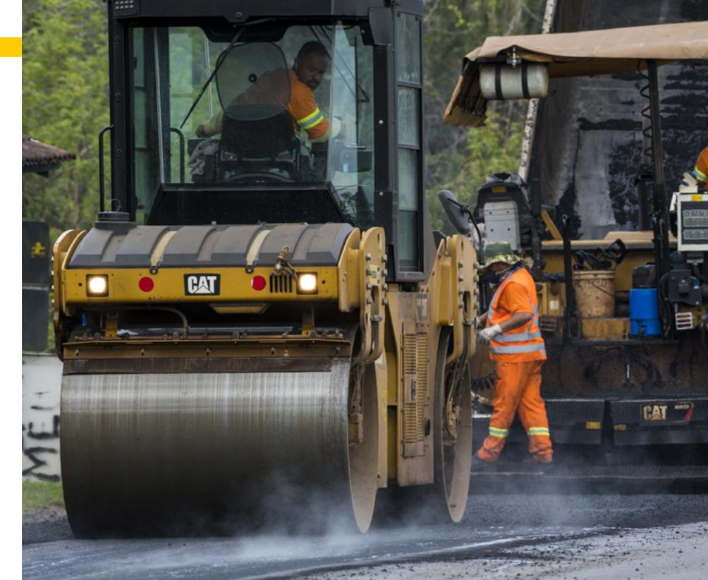
asfálticas. Algumas estradas possuem apenas uma camada, mas outras possuem duas ou três. As camadas inferiores de pavimentos asfálticos normalmente têm granulometria mais grossa, projetada para receber a carga dos veículos que trafegarão sobre ela. A camada superior, também conhecida como camada de rolagem, normalmente é mais fina para dar maior conforto e segurança ao usuário.
